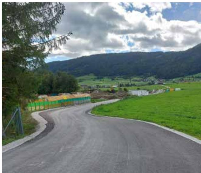
Im Bereich der Forstverwaltung wurde die Asphaltdeckschicht erneuert und die Frostschäden in diesem Bereich behoben.
